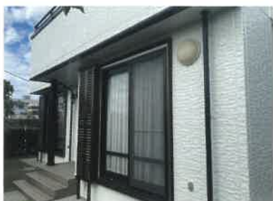
施工後の外壁(拡大写真)
